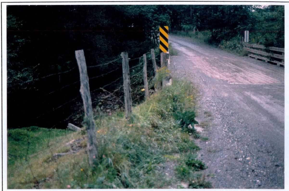
Photo 27: Projet 5373-9708 Chemin Pinacle, secteur 1 (côté sud), Abercorn (N-O)
