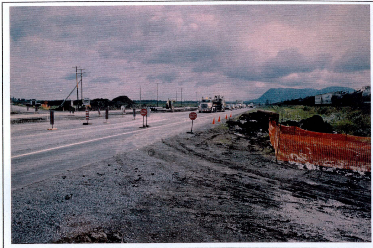
Photo 1: Projet.5371-8615 Route 116, vue générale à 9+800, St-Basile-le-Grand - McMasterville (N-E)
