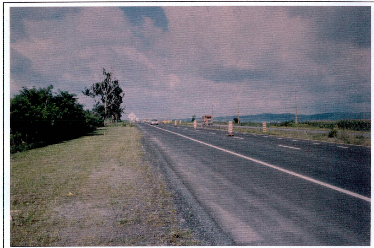
Photo 2: Projet.5371-8615 Route 116, vue générale à 11 + 120, St-Basile-le-Grand - McMasterville (N-O)
