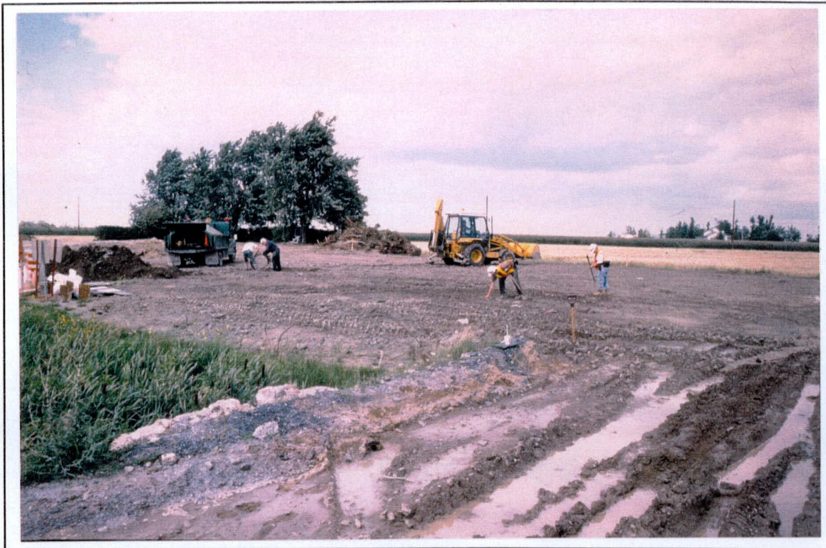
Photo 15: Projet 5372-8802 route 235, vue à 2 + 380, secteur 2, St-Hyacinthe et St-Thomas-d'Aquin (N-E)
