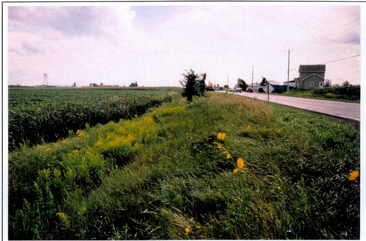
Photo 16: Projet 5372-8802 route 235, vue à 2 + 380, secteur 4, St-Hyacinthe et St-Thomas-d'Aquin (S-S-E)
