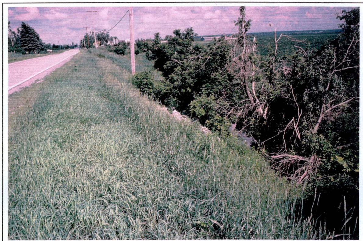
Photo 22: Projet 5372-9603 Chemin St-Dominique, fossé, secteur 2, St-Valérien-de-Milton, (S-E)
