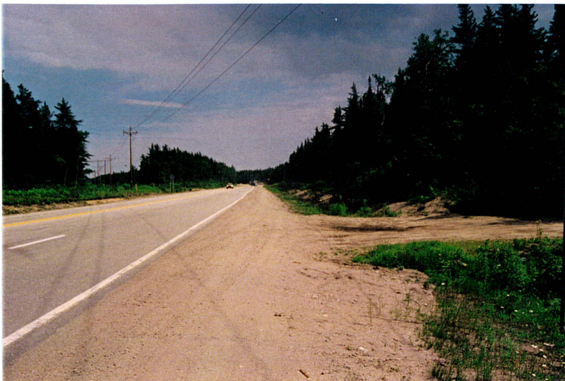
Photo 1 Projet 3574-8601, route 138, construction de la route, Forestville, 8+540-8+300 (SE)
