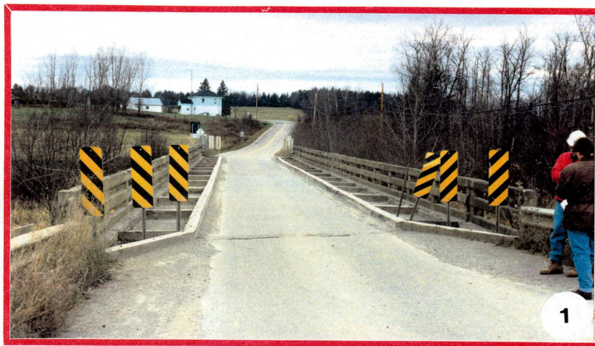
VUE D'ENSEMBLE DU TABLIER DU PONT RÉTRÉCI À UNE VOIE DE CIRCULATION
