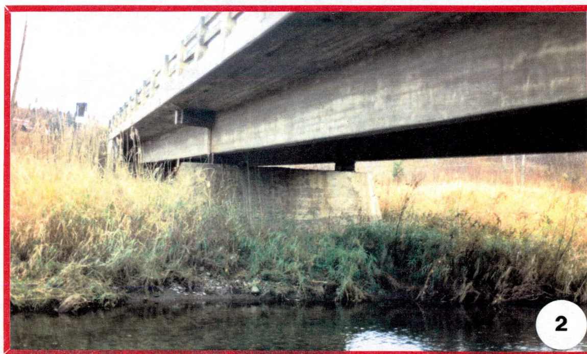
STRUCTURE DE BÉTON DU PONT ACTUEL
