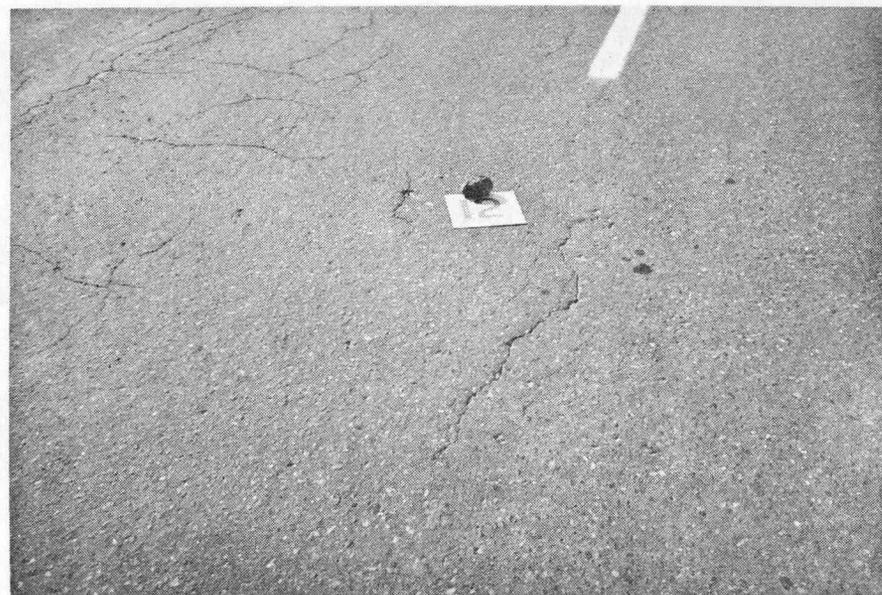
**Photo no6: FISSURES DE RETRAIT "SHRINKAGE"**
