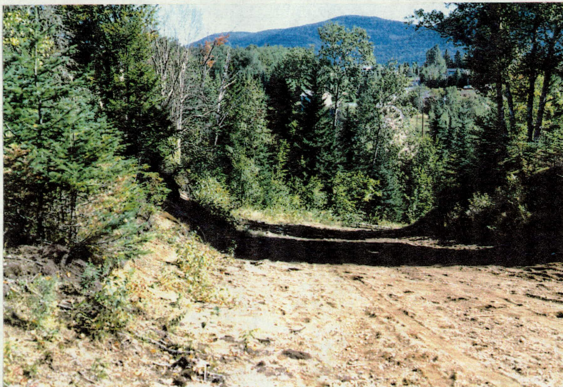
Photo 2: Pente abrupte entre les km 1+036 et 1+146 (section 4), vers le nord-est.
