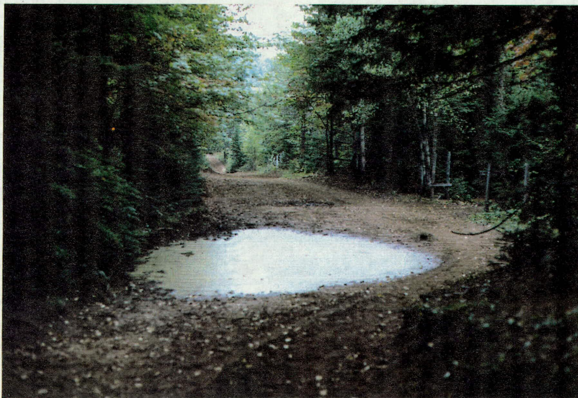
Photo 9: Vue de la section 1, entre les km 0+350 et 0+200, vers l'ouest.
