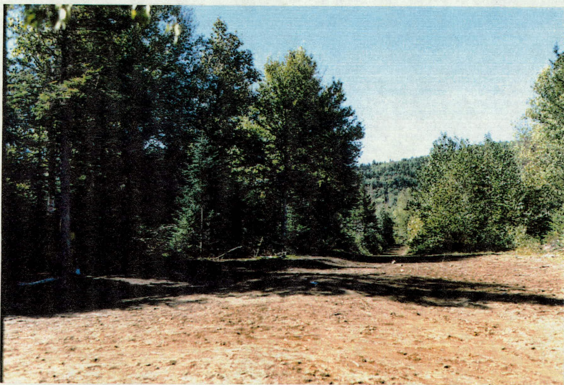
Photo 12: Vue de la section 3, entre les km 1+036 et 0+900, vers l'ouest.
