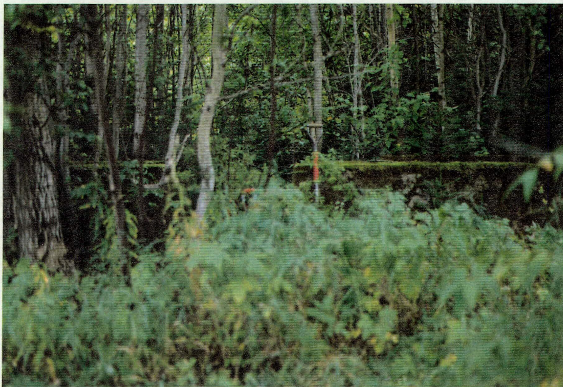
Photo 19: Mur est de la structure no 1, vers l'ouest.
