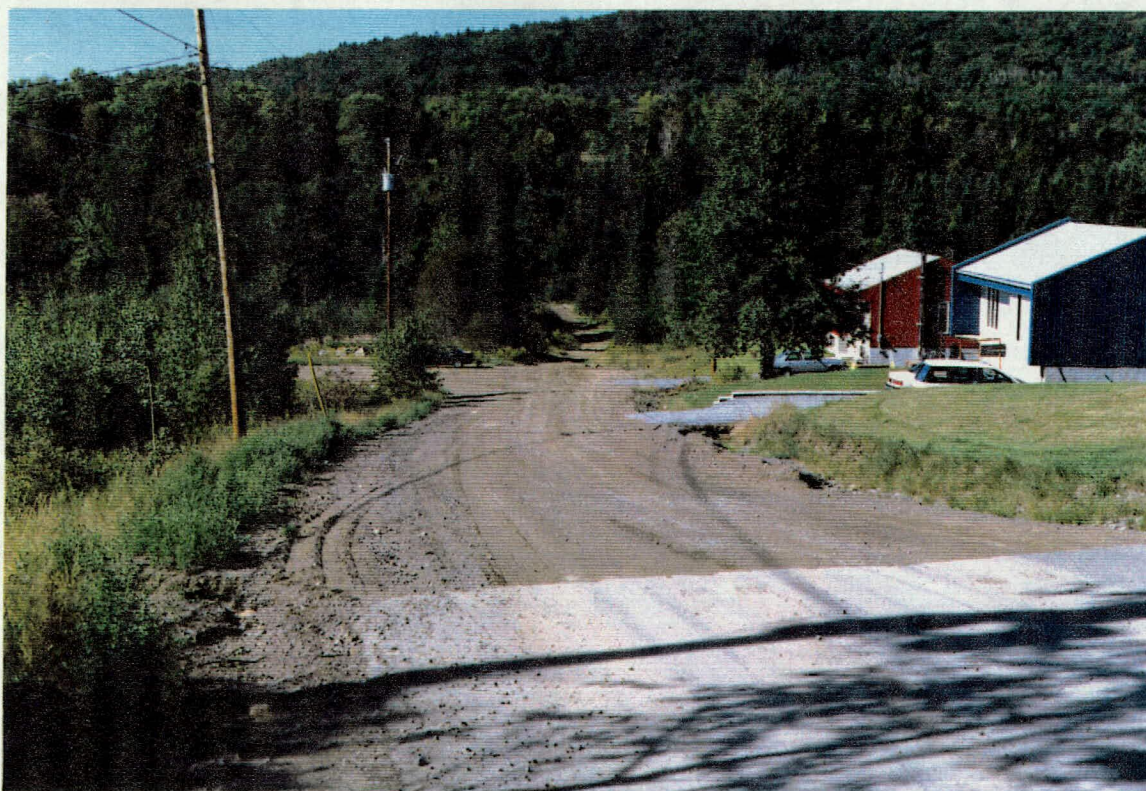
Photo 6: Début de l'emprise, extrémité est, section 4, km1+350, vers l'ouest.
