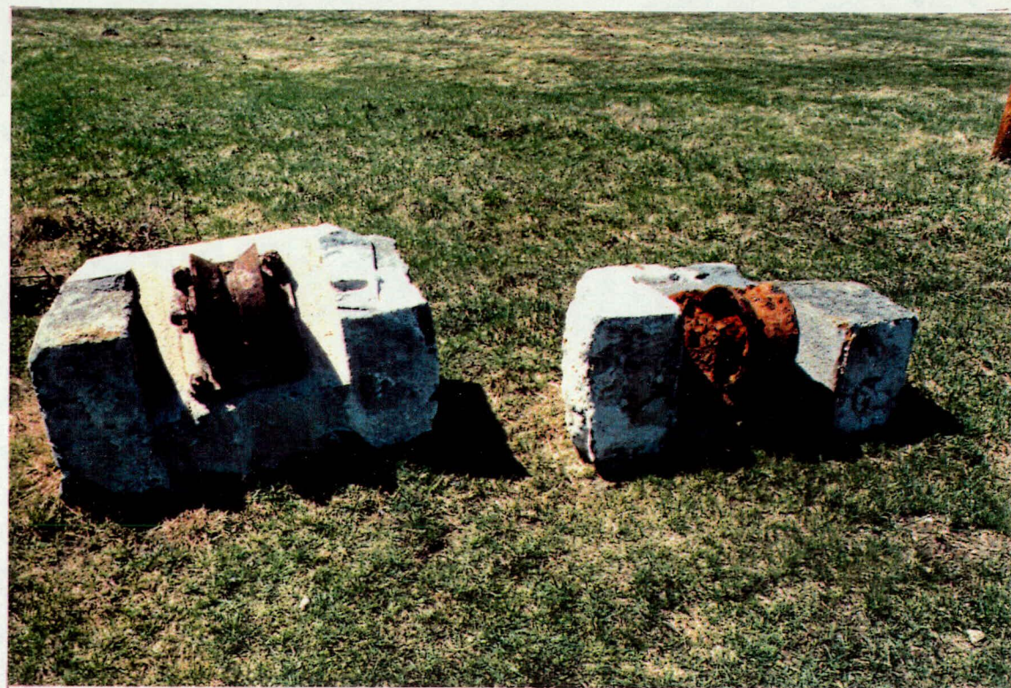
Planche 7. Poulies autour desquelles roulaient les chaînes reliées aux treuils manuels qui commandaient l'ouverture et la fermeture des portes d'écluses. Ces poulies ont été mises au jour lors des travaux d'excavation réalisés en 1987 par la Voirie de Melocheville sur le site de l'écluse no.5.
