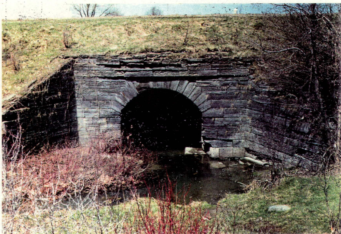
Planche 2. Aqueduc de la rivière Saint-Pierre (ruisseau du Tré-Carré à Saint-Timothée).
