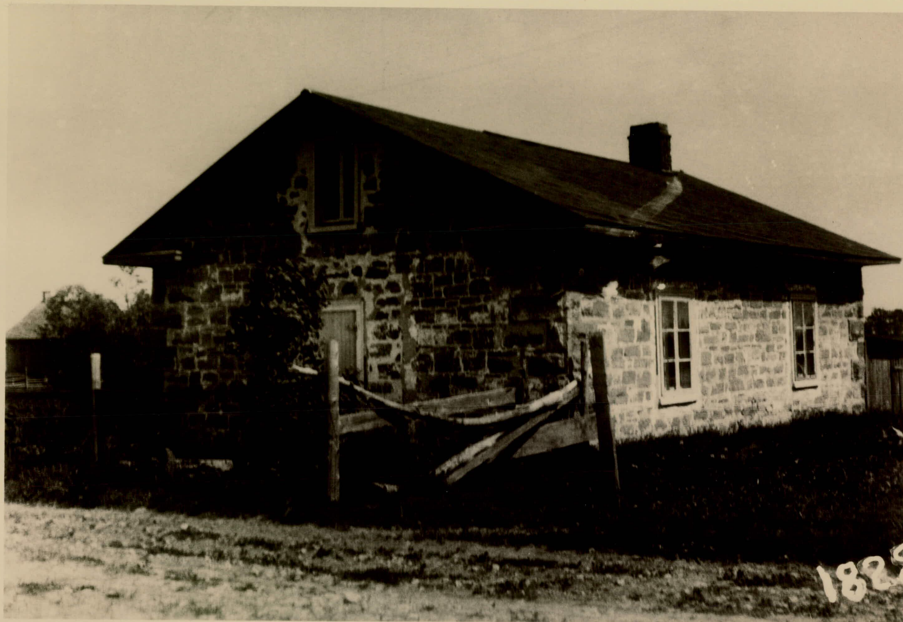
AP.5 Maison de l'éclusier, écluse no.7, avril 1933 (Archives publiques du Canada: C 63689).
