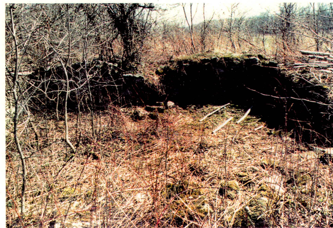
Planche 5. Aqueduc de la rivière Saint-Pierre (ruisseau du Tré-Carré à Saint-Timothée).
