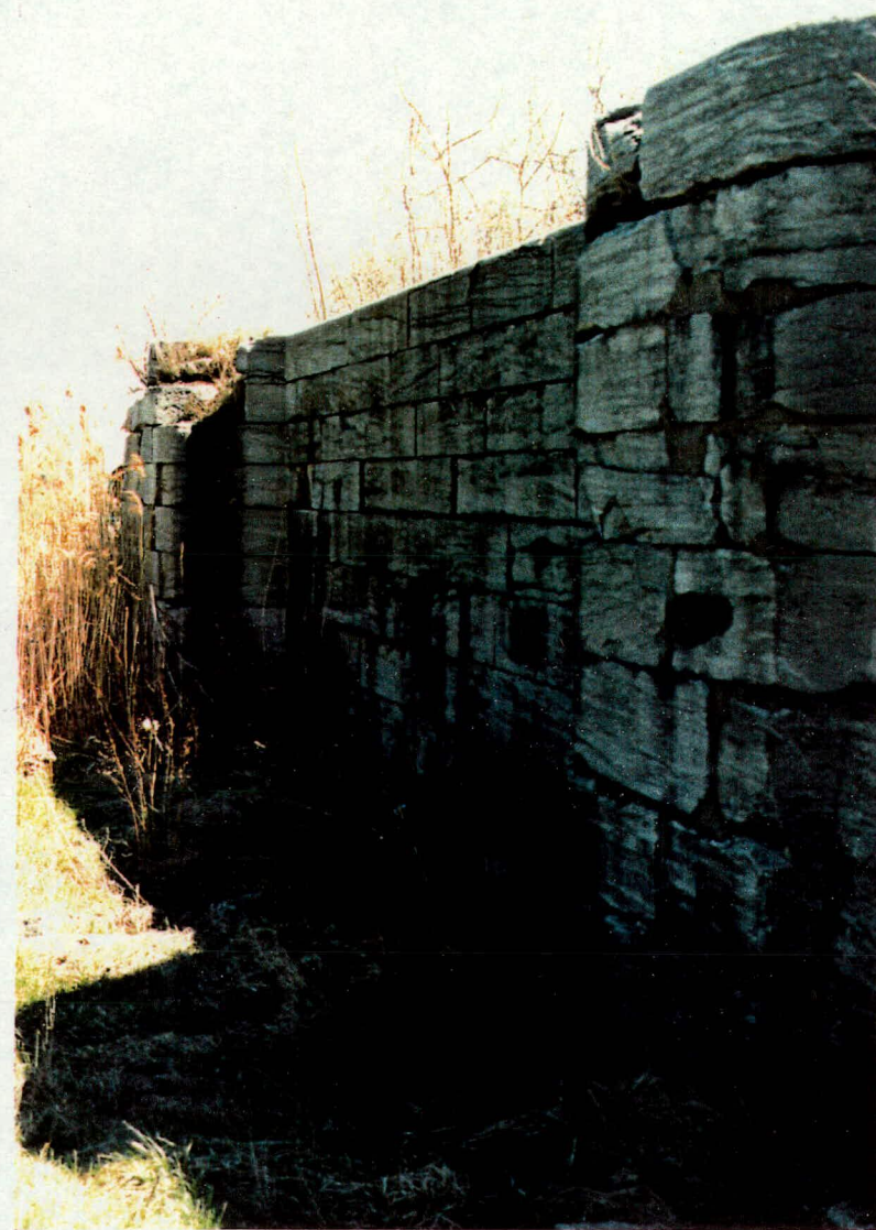
Planche 6. Segment du mur de la chambre de l'écluse no.4 (rue du Canal, municipalité de Melocheville).
