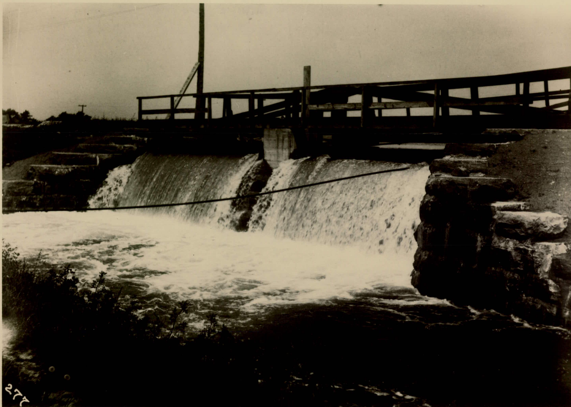
AP.3 Déversoir situé entre les écluses nos.2 et 3, 21 juin 1906 (Archives publiques du Canada: C 63683).
