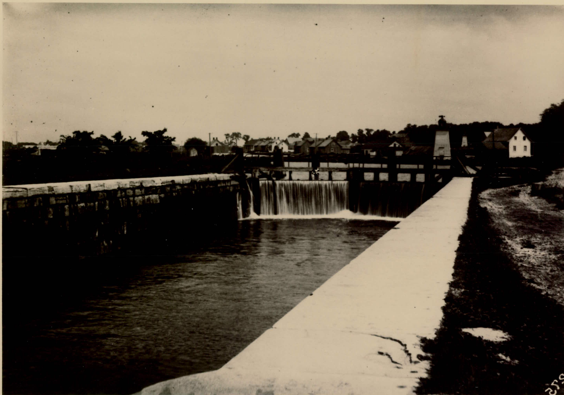
AP.1 Ecluse no.1, vue vers l'ouest, 21 juin 1906 (Archives publiques du Canada: C 63898).
