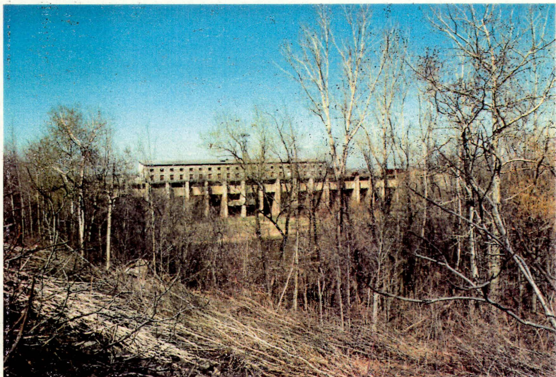
Planche 1. La centrale de Saint-Timothée et son réservoir (vue générale d'amont).
