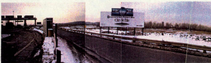
7- Vue de la voie de service située au nord de l'emprise du pont Champlain
