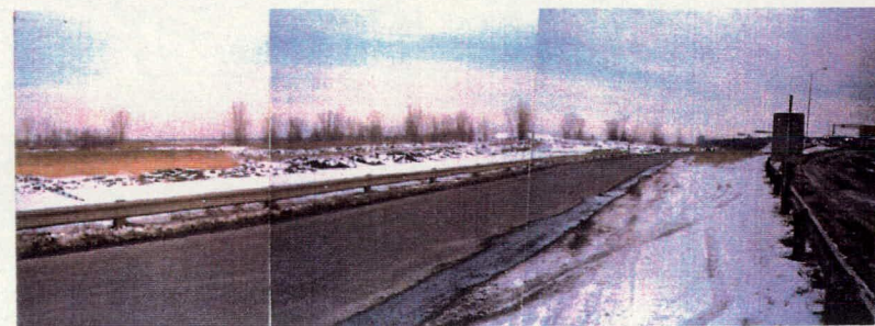
8- Vue de la voie de service située au nord de l'emprise du pont Champlain
