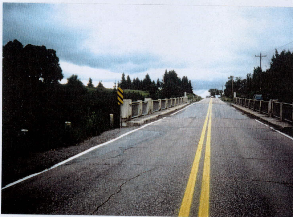
Photographie 4.1: Vue générale du pont. Orientation SE
