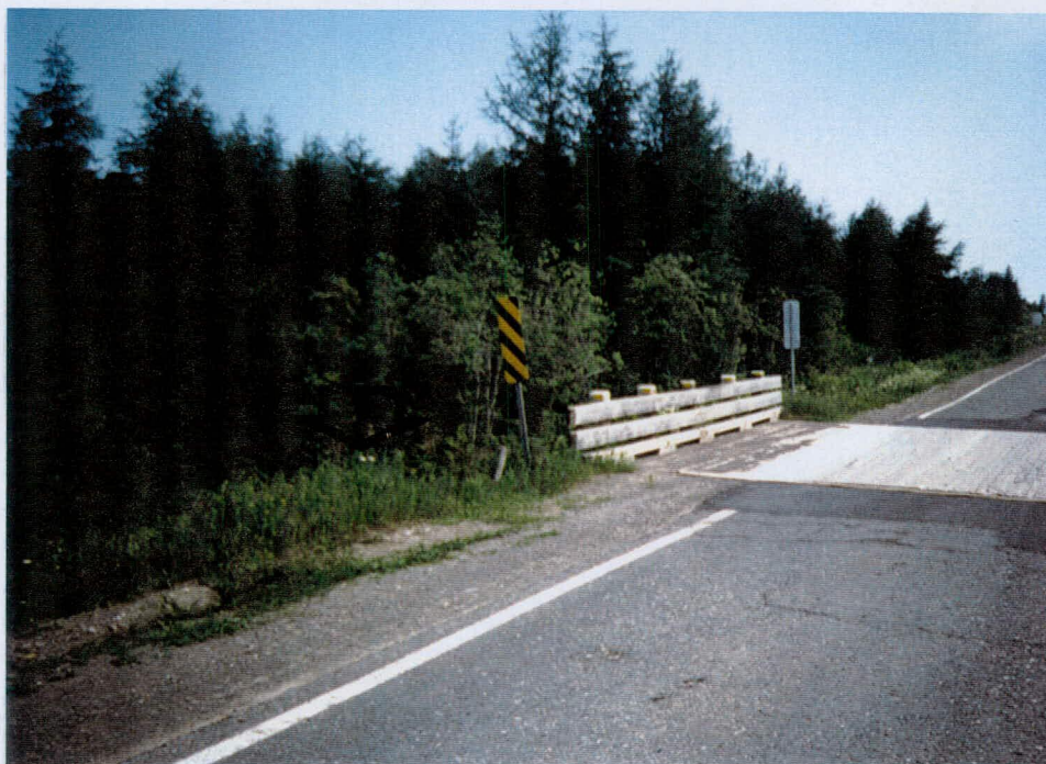
Photographie 1.11: Vue générale du secteur 1, du pont et du fossé où sera localisé le chemin de détour. Orientation SE
