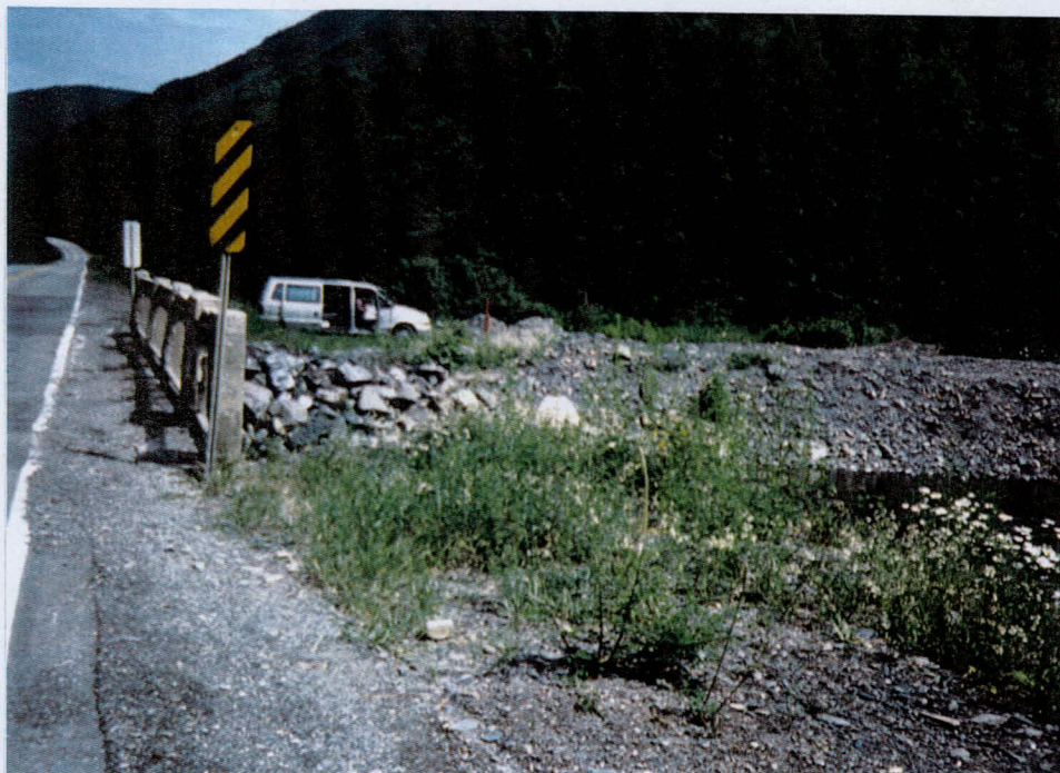
Photographie 1.24: Vue générale du pont et des emprises. Orientation NO
