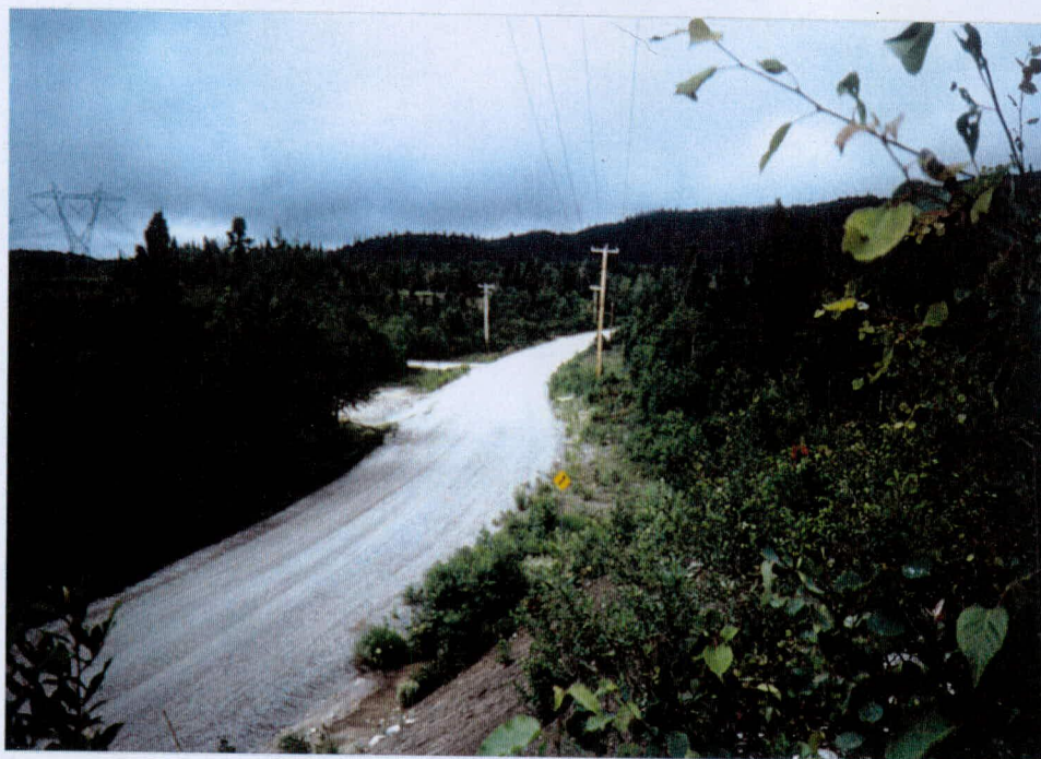
Photographie 3.8: Tronçon 4, secteurs 4 à 6. Vue générale du projet, prise du haut d'un talus au km 18 + 460. Orientation O
