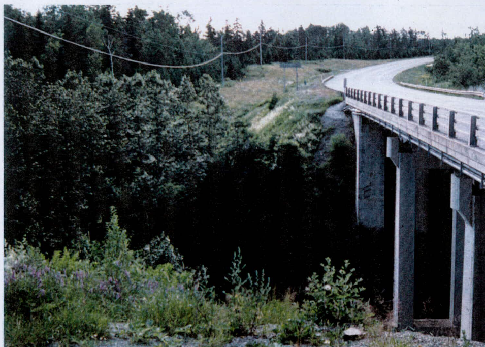
Photographie 2.6: Vue générale des abords du pont de la rivière Verte, du côté nord du pont. Orientation E
