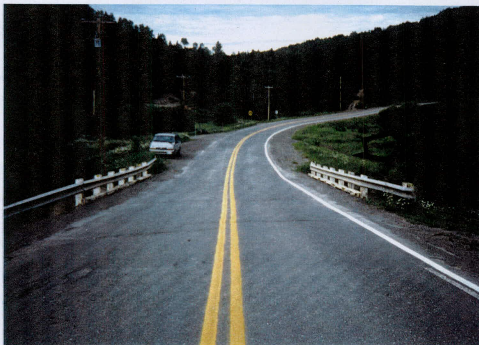
Photographie 1.9: Vue générale du pont actuel et des approches, ainsi que de l'emplacement du chemin de détour. Orientation NE à SE
