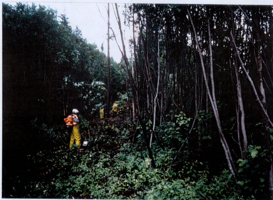
Photographie 3.4: Tronçon 3, secteur 3. Vue générale de l'emprise nord, prise au km 15 + 760. Orientation E
