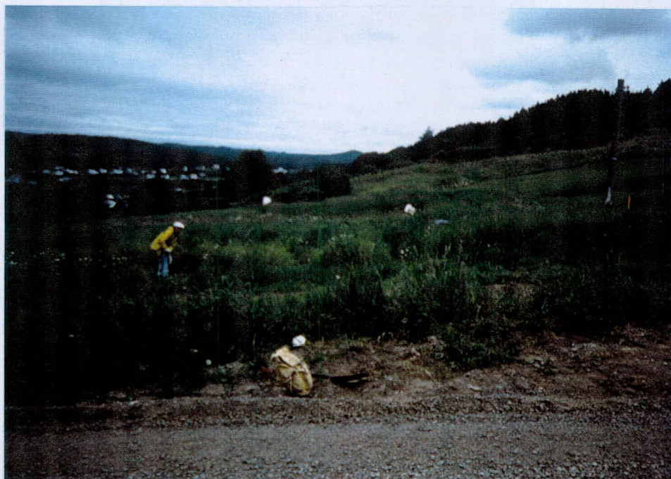
Photographie 1.19: Vue du secteur 9 (chemin de détour), exécution des sondages, prise du km 0 + 000. Orientation S
