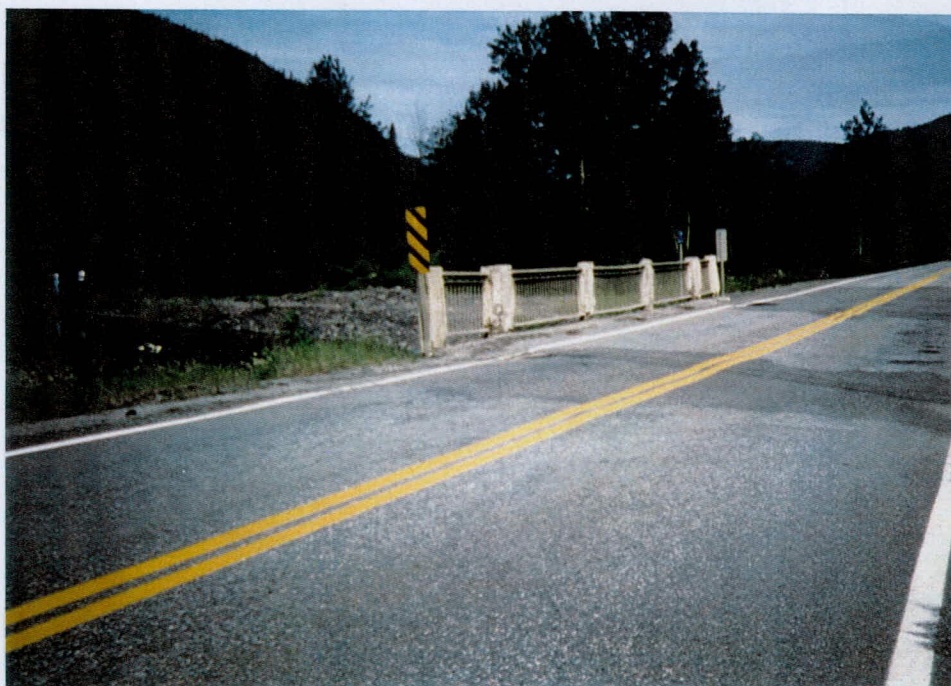
Photographie 1.25: Vue générale du pont et des emprises. Orientation NE
