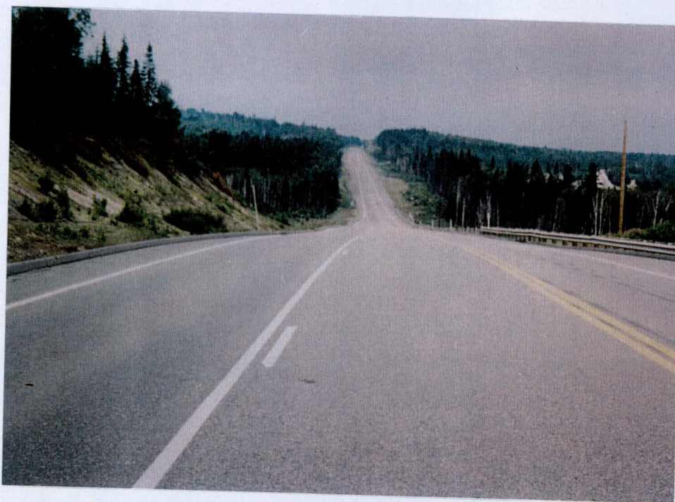
Photographie 2.16: Vue générale du secteur 1, prise du km 204 + 160. Orientation NO à NE
