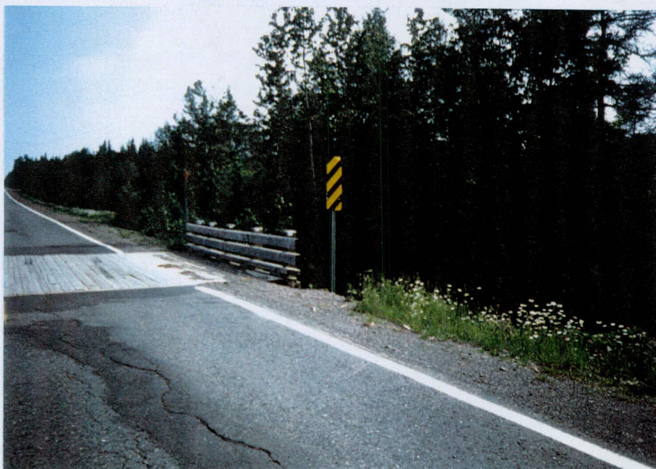
Photographie 1.13: Vue générale du secteur 2 et du pont. Orientation SO
