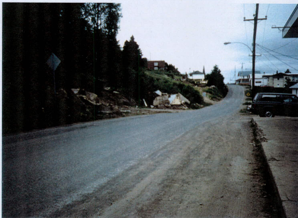
Photographie 1.18: Vue générale du secteur 1, en direction du début du projet, prise du km 0 + 260. Emprise perturbée par maisons déplacées. Orientation SO
