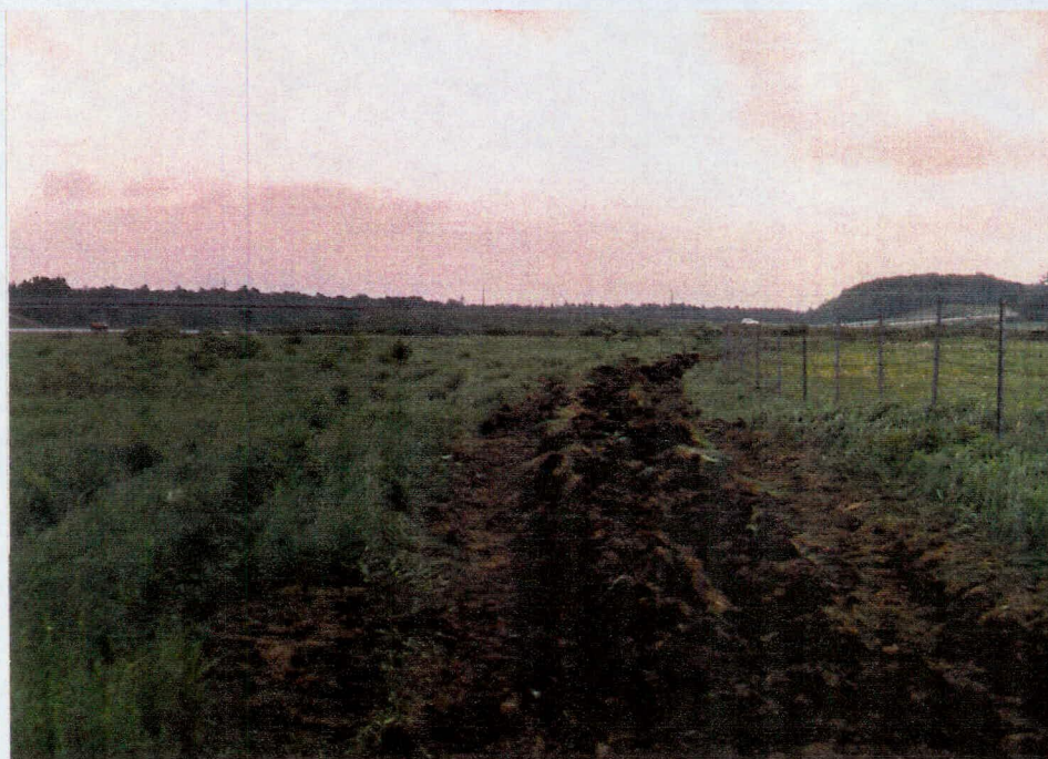
Photo 16. Secteur 8, zone bouleversée par les travaux de Québec-Téléphone
