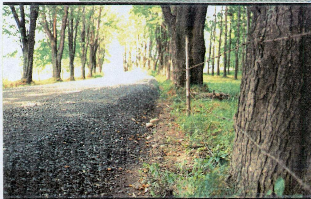
PHOTO 26 Protection des arbres à l'intérieur d'un tunnel végétal en dégagant la base des arbres lors du rechargement
